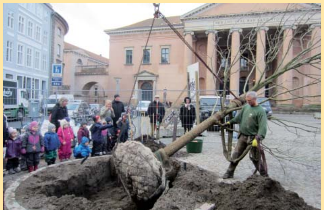
Et godt eksempel på plantning på offentligt, befæstet areal - Nytorv i København får plantet en stor eg. Bemærk det store plantehul og den høje kant omkring plantebeddet.
